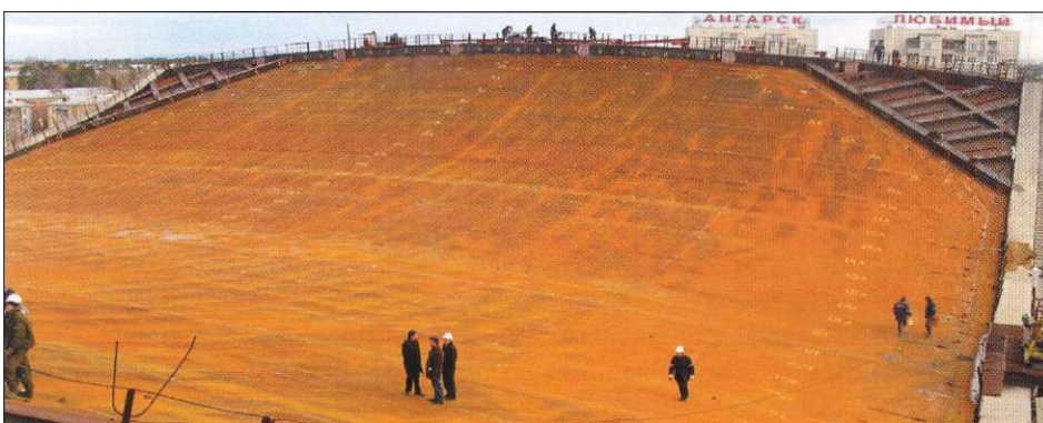
Рис. 7. Окончательная рихтовка и заварка листов мембраны между собой и с опорным контуром
