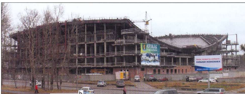
Рис. 2. Мембранное покрытие арены «Ермак» в г. Ангарске
