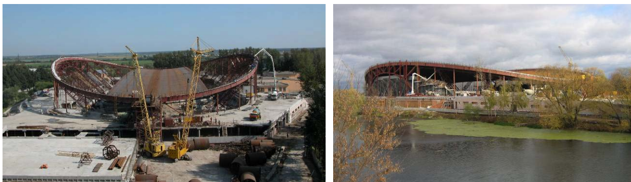
Рис. 1. а) Подача рулонированных полотнищ мембраны, их раскатка по временным элементам постели. б) Законченное мембранное покрытие, вид с противоположного берега реки Коломенка
